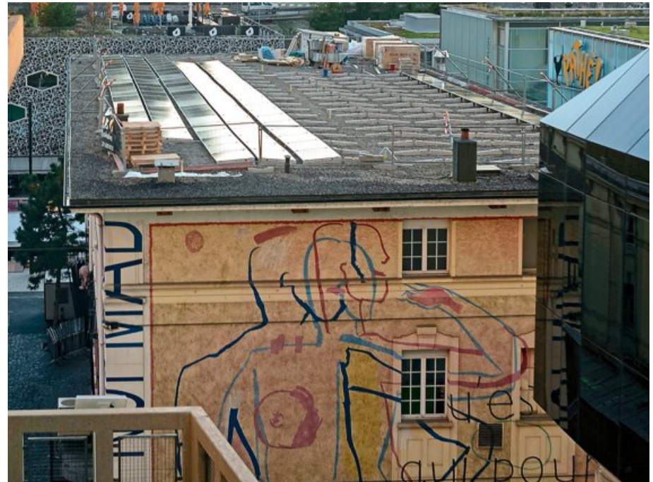
La pose des panneaux solaires vient de débuter sur le toit. L'été prochain, ce sont les façades qui changeront d'apparence pour défendre la cause écologique. PATRICK MARTIN
